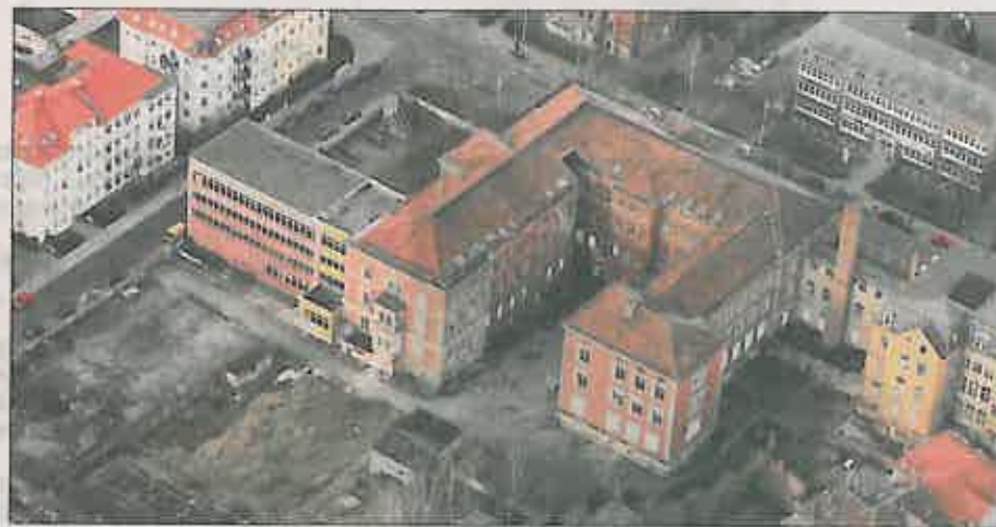
AUSBAU: Mit dem rechten nach innen ragenden Altbauflügel wird begonnen.
